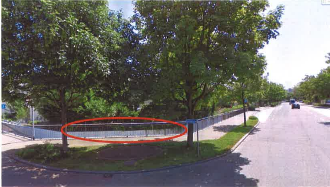
Standort 4 Walliseller-/Dorfstrasse, Unterführung
