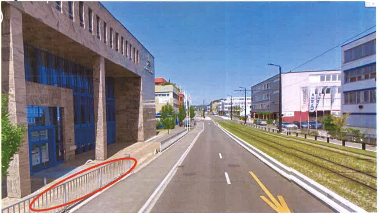
Standort 3 Flughofstrasse, UBS Card Center
