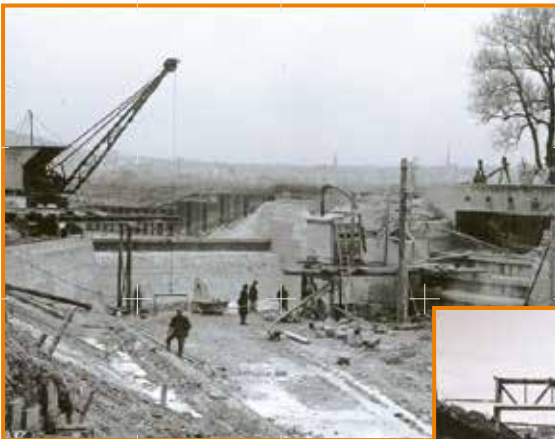
Bau der Staustufe bei der Mündung des Leutschenbachs ca. 1938
