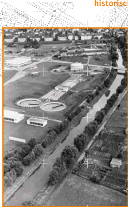
Die ARA der Gemeinden Kloten und Opfikon im Rohr im Juni 1966
