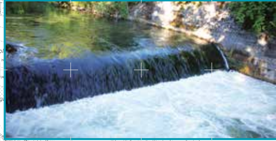
Staufstufe mit Wasserwalze nahe der Ermündung des Leutschenbachs
