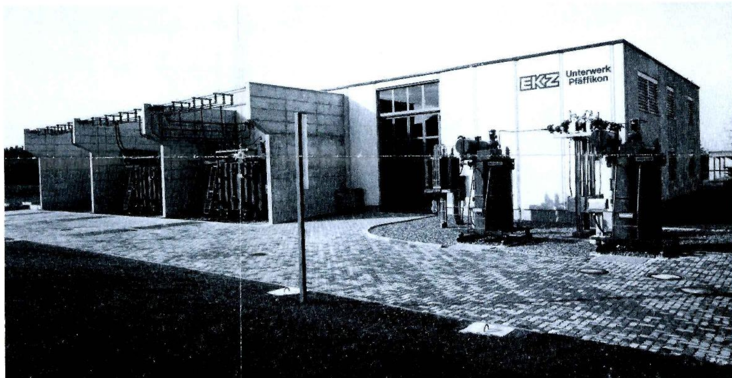
Ansicht eines ähnlichen Unterwerks in Pfäffikon (ZH) mit den Reguliertransformatoren in den Aussenzellen
