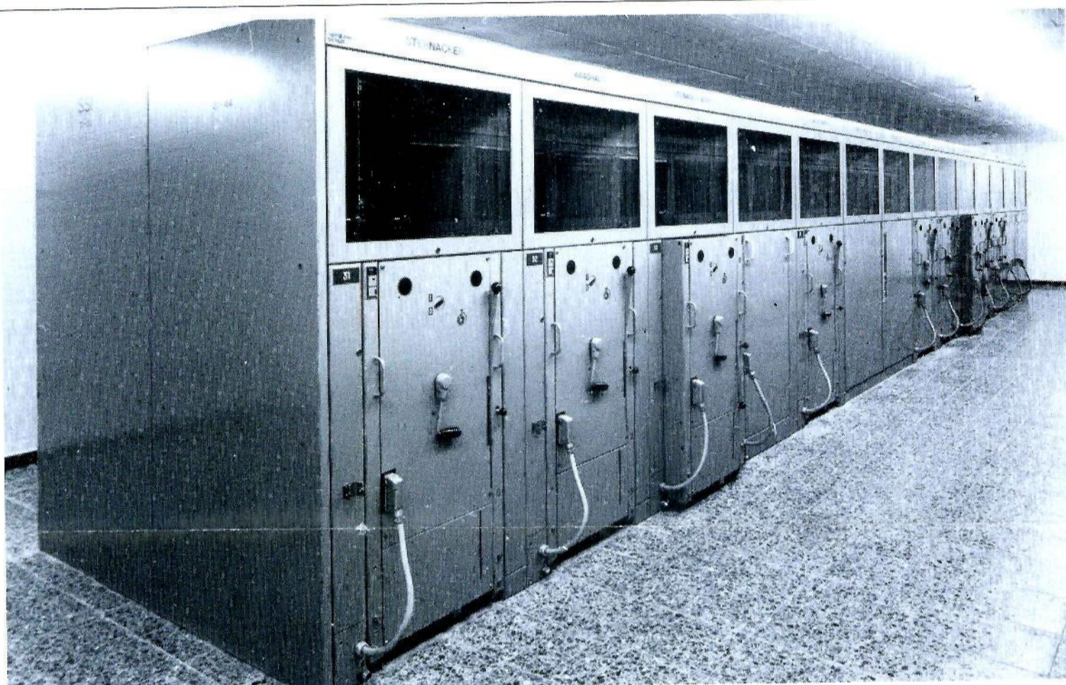
16-kV-Hochspannungsanlage mit Duplexzellen
