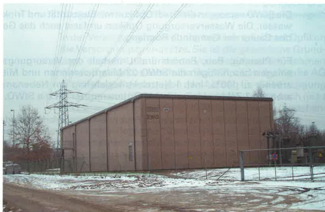
Das Unterwerk Opfikon an der Zunstrasse 15, im Besitz der EKZ und des EW Opfikon, versorgt seit 1999 die Stadt Opfikon mit elektrischer Energie.
