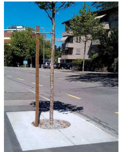
Beispiel: Betonplattenabdeckung bei der Längsparkierung
