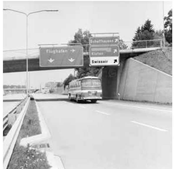
Flughafenautobahn A51, Ausfahrt Glattbrugg / Kloten 1966.
