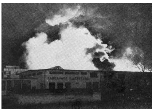
Im Februar 1973 brennt das Lagerhaus der Firma Luchsinger.
