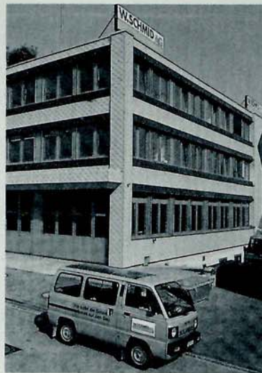
Oben: Die erste integrierte Solarfassade der Schweiz in Glattbrugg.
