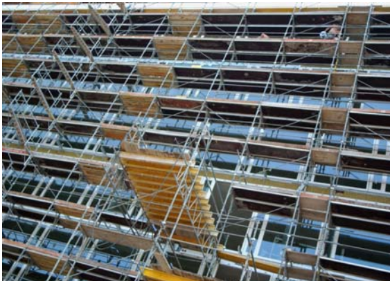
Bild: Gerüst beim Projekt Hotelplan
