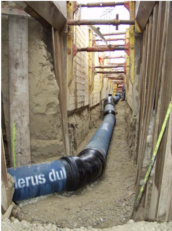
Bild: Wasserleitungsbau für die Erschliessung des Glattparks.
