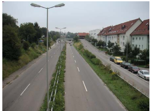
Thurgauerstrasse, nördlicher Abschnitt
