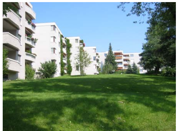
wenig strukturierte und pflegeleichte Aussenräume sind durch geeignete Massnahmen aufzuwerten
